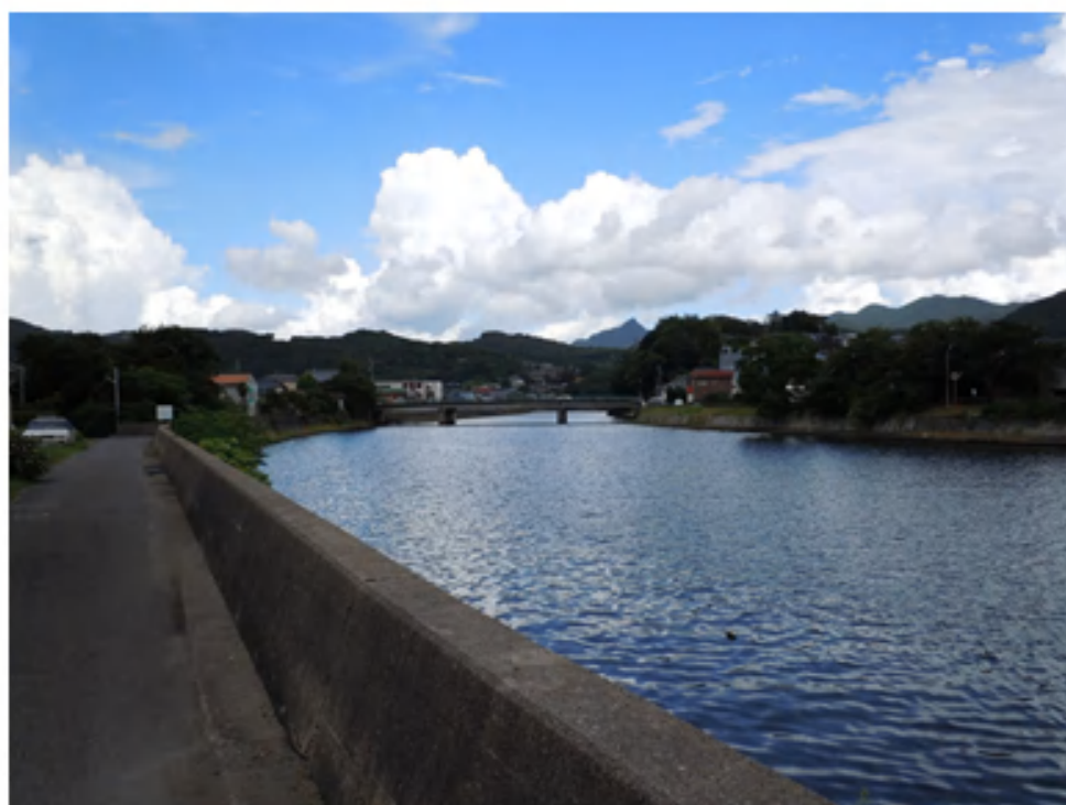
【写真2】 川棚川・江川橋を下流側から見る(2010年8月)
