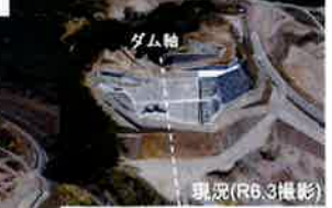
左岸掘削状況
