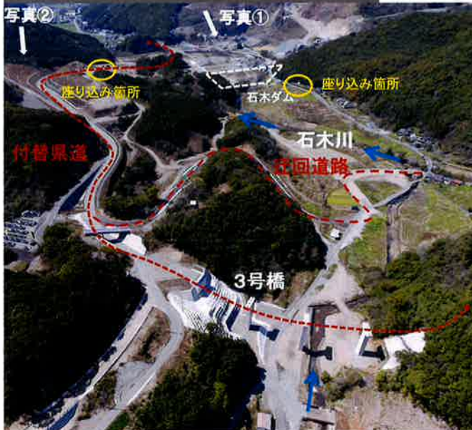
工事現場全景(令和6年3月27日撮影)
