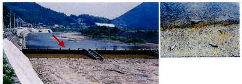
平成6年の渇水状況（山道堰）
